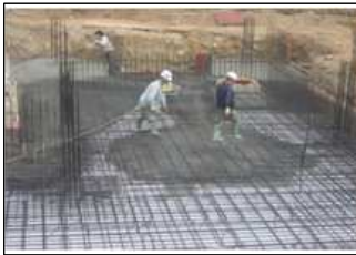
[현장 콘크리트 타설]
