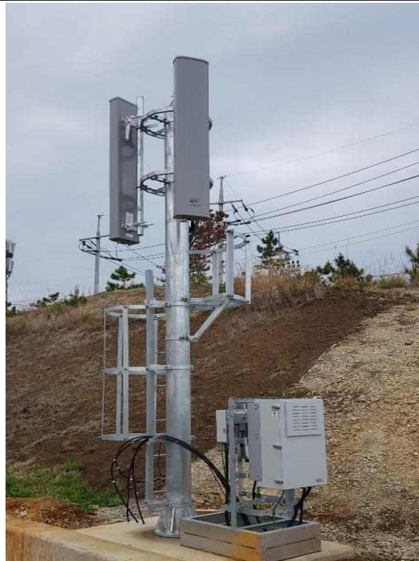
건설구간 단독폴 시공(포항영일만신항)
