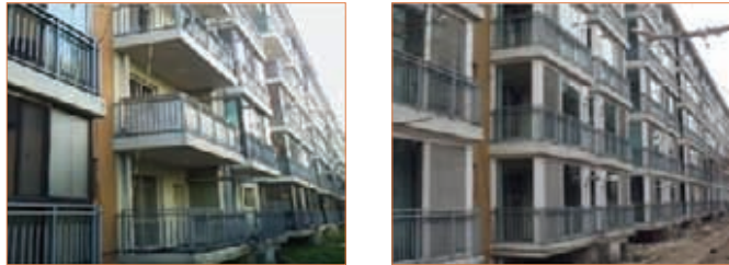
발코니 등에 새시를 설치하거나 기존 창호를 확대 혹은 축소하여 일조환경을 개선
