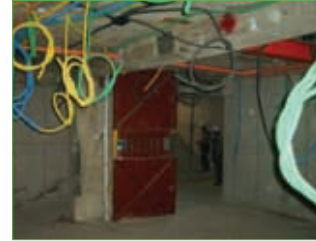
인방보형 제진장치와 댐퍼 설치
