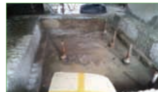
탄소섬유를 이용한 슬래브 보강과 마이크로 파일을 이용한 기초 보강 및 증설
