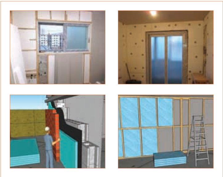
결로 문제를 고효율의 단열재로 교체하여 성능 개선 및 에너지 절약 도모
