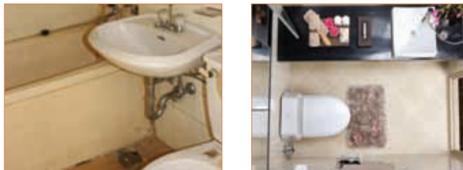
기존의 노후화된 도기를 단순히 교체하거나 시스템형 욕실 설치
