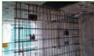
증개축시 신규 내력벽 설치 및 슬래브 형강 보강
