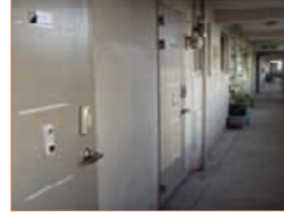
현행 법규에 부합하는 방화문으로 교체하거나 내화, 내연을 위한 이중문을 설치
