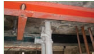
증개축시 신규 내력벽 설치 및 슬래브 형강 보강
