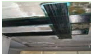
탄소섬유를 이용한 슬래브 보강과 마이크로 파일을 이용한 기초 보강 및 증설
