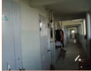
현행 법규에 부합하는 방화문으로 교체하거나 내화, 내연을 위한 이중문을 설치
