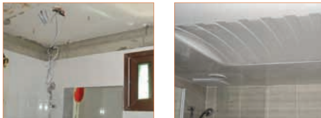
소음 저감재 설치 및 배관주변 기밀성 확보를 통한 소음의 최소화
